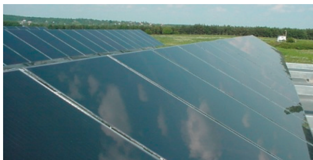
1. ábra. Az amorf és polikristályos napelem
