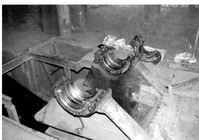
1. fénykép. Magnezittörő berendezés főtengely csapágyfészkek
