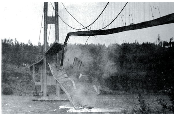
1. ábra A Tacoma-híd leszakadása, 1940. november 7. Egy hibásan kialakított modellnek katasztrofális következményei lehetnek. [1]
