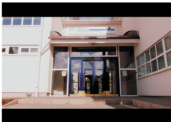
1. ábra. A Tudástranszfer központ épülete
