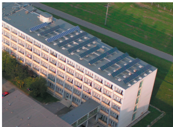
1. ábra: A SZIE C kollégium tetején felépített 10 kWp teljesítményű fotovillamos rendszer
