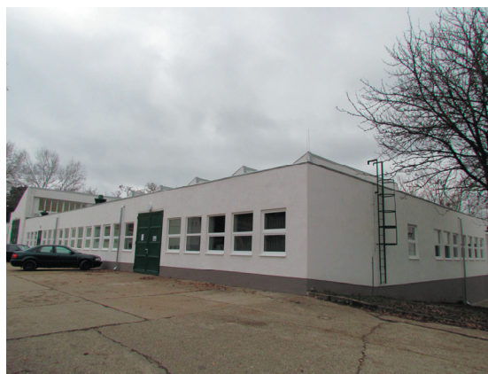
8. ábra. A felújított tanműhely blokkok épülete
