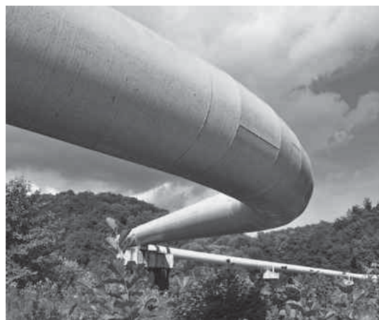
1. ábra Földfeletti többtámaszú csővezeték
