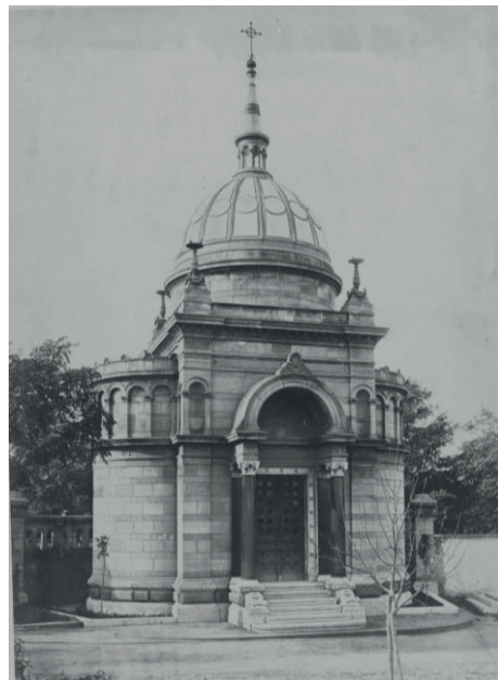
4. ábra. Ganz Ábrahám mauzóleuma a Fiumei úti sírkertben (tervezte Ybl Miklós)
